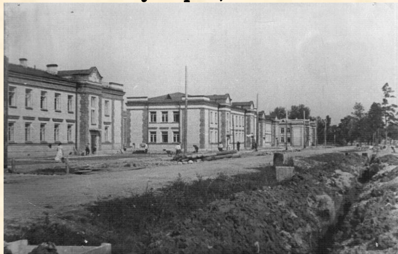
Строительство в Сосновой Поляне. Август, 1939 г.
